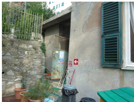
Figura 4.2 - Particolare della copertura
