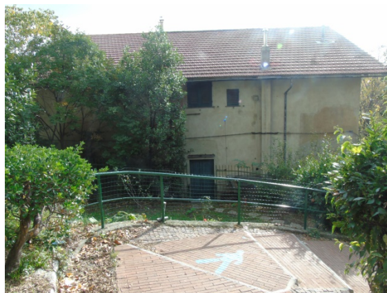
Figura 8.1 - Particolare copertura su cui intervenire.
