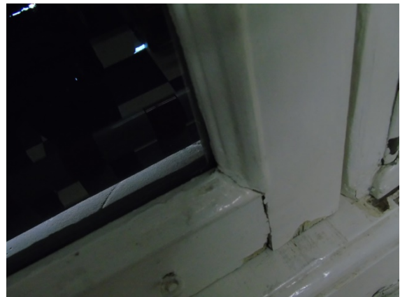
Figura 4.4 - Particolare dei serramenti
